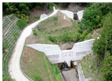
不透過+透過型堰堤工
