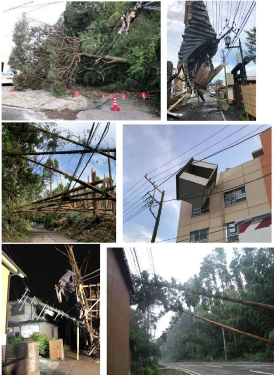
写真1_台風第15号による主な被害状況 (台風15号対応検証委員会報告書(最終報告) _2020.1.16(東京電力ホールディングス(株)) (以下「東京電力最終報告」という。)より)
