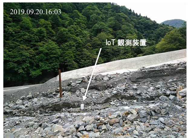
図6 画像観測ユニットから自動送信された画像1 （降雨前のIoT 観測装置と春木川の流れの様子）
