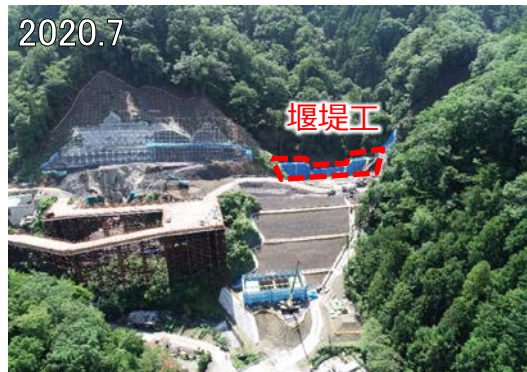
大規模切土工区の掘削状況 (大島地区)
