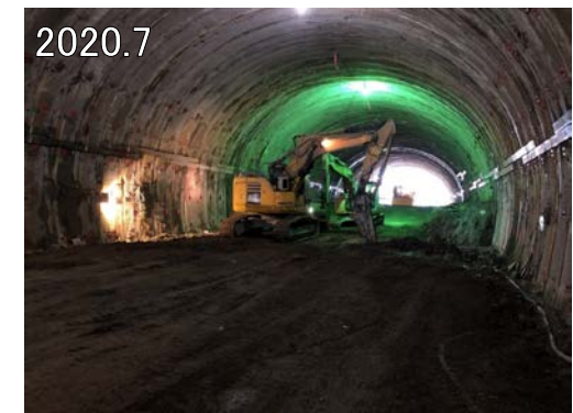
トンネル インバート工施工状況 (下八木沢第一トンネル)
