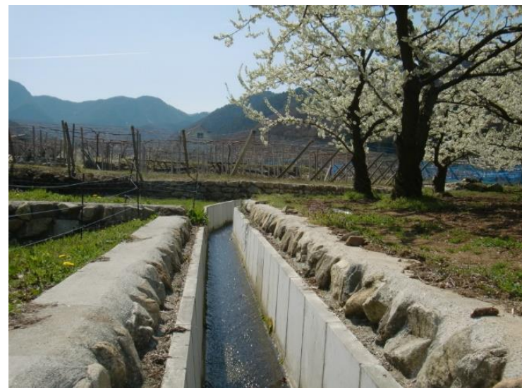
完成後 水路整備により、もも、ぶどうの生産性が向上するとともに、維持管理が大幅に軽減された。
