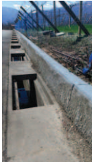
◀ 柵の下がコンクリートで電気柵のアースが確保できない(灰色部分)
