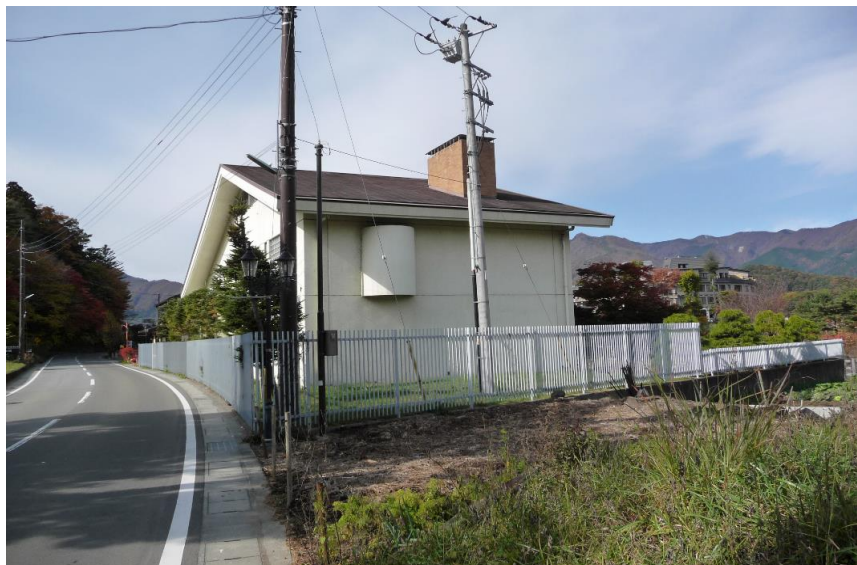
河口湖第一中継ポンプ
