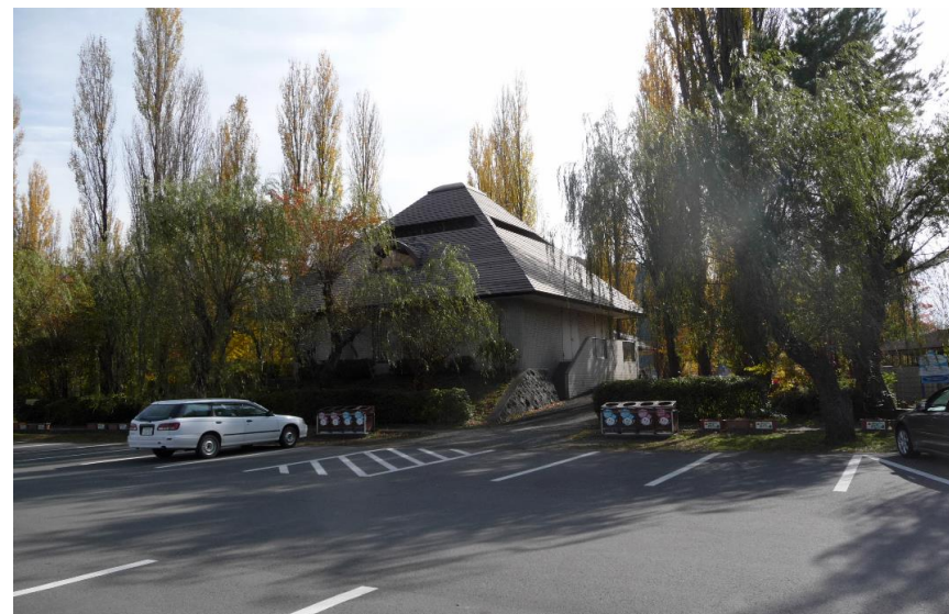
河口湖第二中継ポンプ
