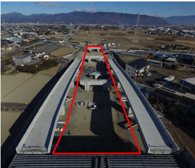
架橋位置写真
