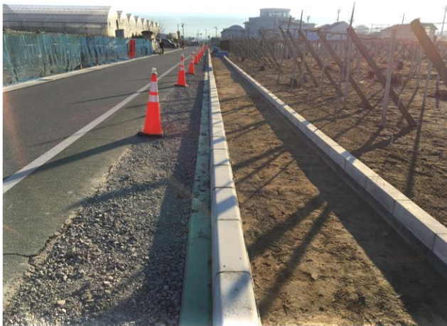
縁石工(歩道設置)
