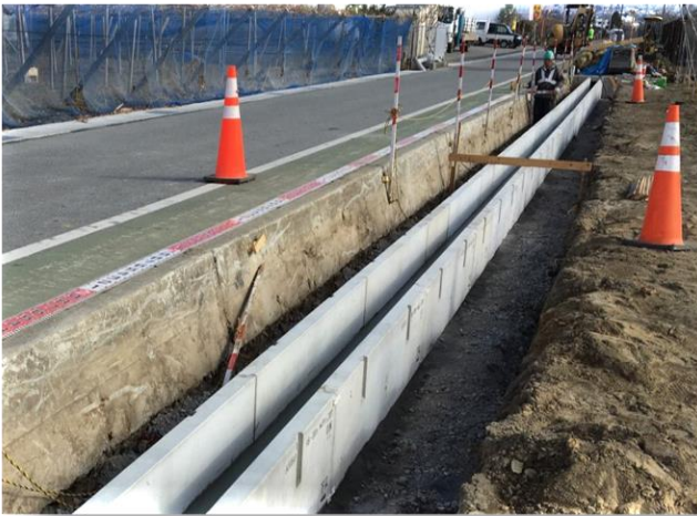
箱型側溝工
