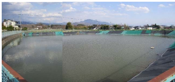
④ 下井出ため池 全景 安全率(地震時) 1.84 > 1.20 (基準値) 貯水量 5,000m 3 、堤高 H=2.9m
