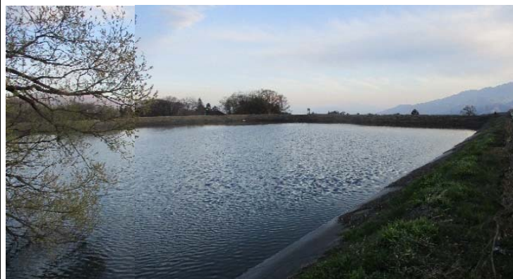
① 観音第一ため池 全景 安全率(地震時) 0.63 \leq 1.20 (基準値) 貯水量 33,000m 3 、堤高 H=7.0m
