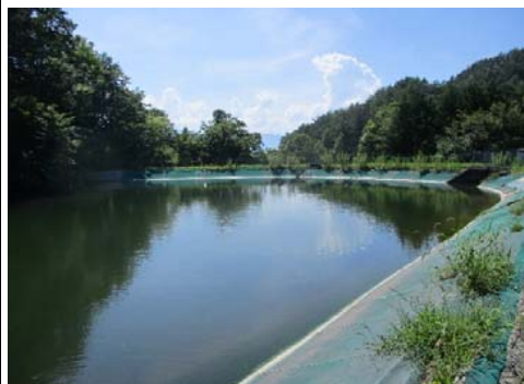
④ 和田ため池 全景 安全率(地震時) 1.01 \leq 1.20 (基準値) 貯水量 6,000m 3 , 堤高 H=10.4m
