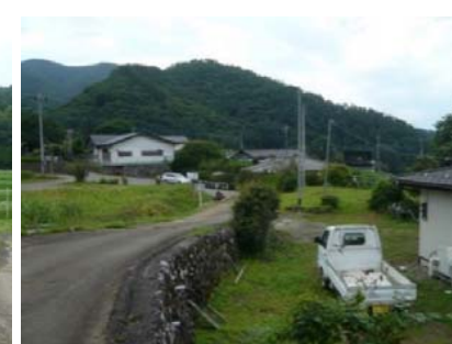
⑦ ため池下流には集落があり、大型地震の際には甚大な被害のおそれがある。
