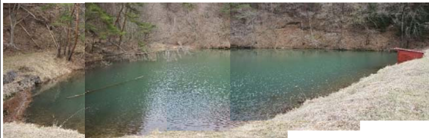
① 松尾沢ため池 全景 安全率(地震時) 1.02 \leq 1.20 (基準値) 貯水量 18,000m 3 , 堤高 H=15.7m
