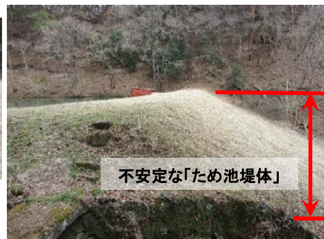
② 堤体の安定性が確保されておらず地震時に堤体が決壊する危険がある。
