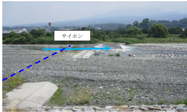
① 四ヶ村堰 全景
