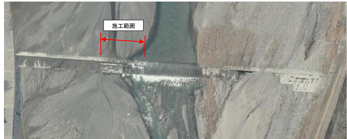
施工範囲は、河川管理者との協議により選定し、不安定な箇所を補修する。
