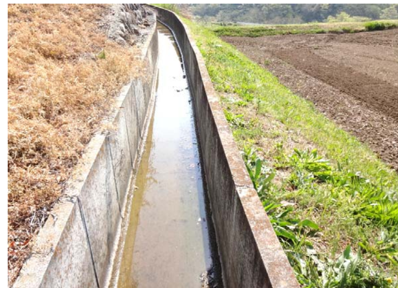
完成後 用排水路の整備により、安定した用水が確保されるとともに、維持管理労力が軽減され、生産効率が向上した。
