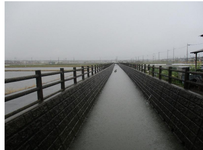
④ 整備後： 排水路の排水状況
