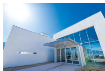
5 米倉山次世代エネルギーシステム研究開発ビレッジ(Nesrad) 日本を代表する燃料電池評価機関であるFC-Cubicなど、水素・燃料電池、蓄電システムにおける世界最先端の研究を行う企業・団体が入居
