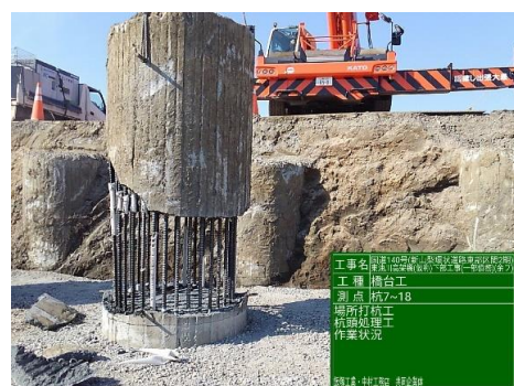
場所打ち杭工 杭頭処理状況
