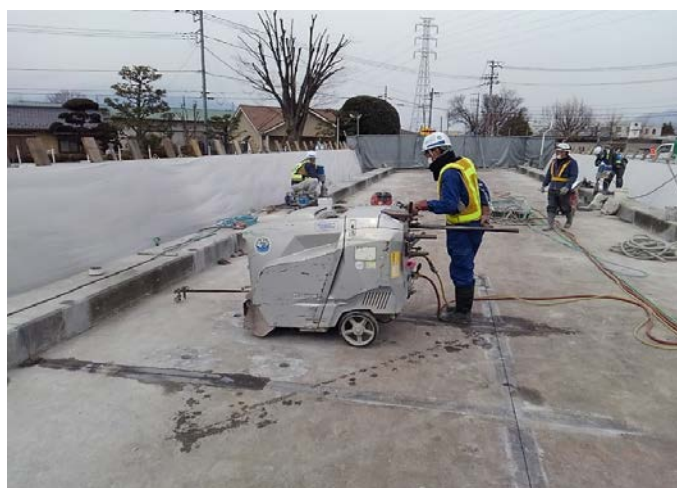
床版切断状況
