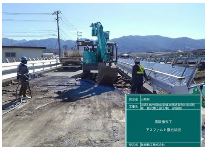
舗装版撤去状況
