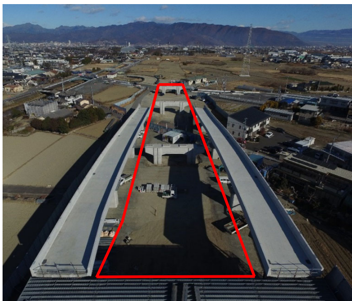
架橋位置写真
