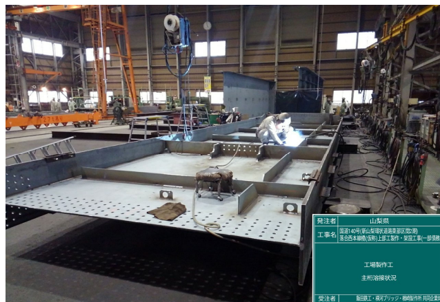
工場製作状況
