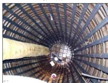
鉄製支保工の土留
