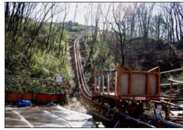
モノレールの仮設
