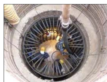
コンクリート打設
