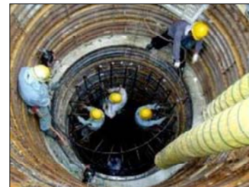
躯体部の配筋
