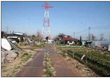
平野部の仮設搬入路(鉄板養生)
