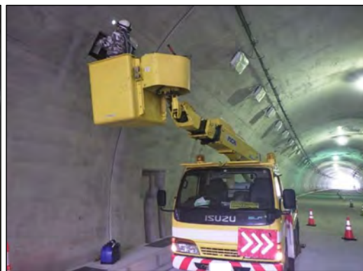
照明工事の施工 (イメージ)
