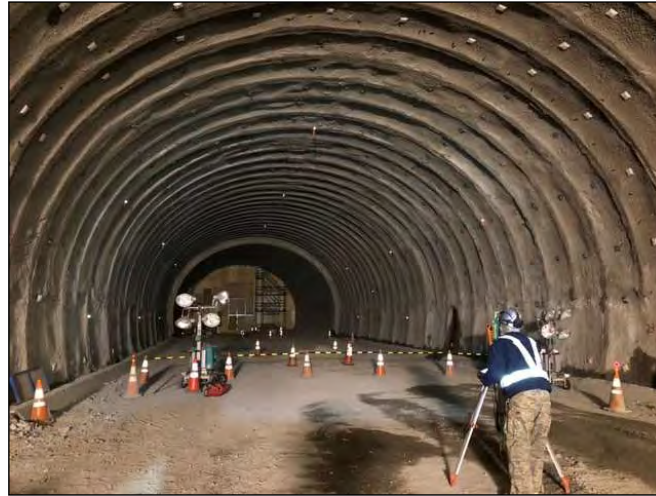
覆工取り壊し後の地山計測状況 (2月11日完了)
