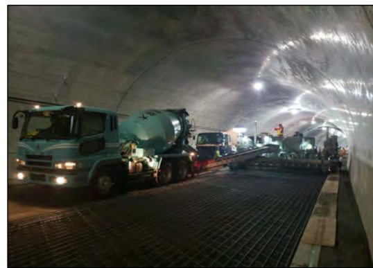
舗装工事の施工 (イメージ)
