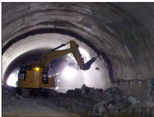
覆工取り壊し施工の状況
