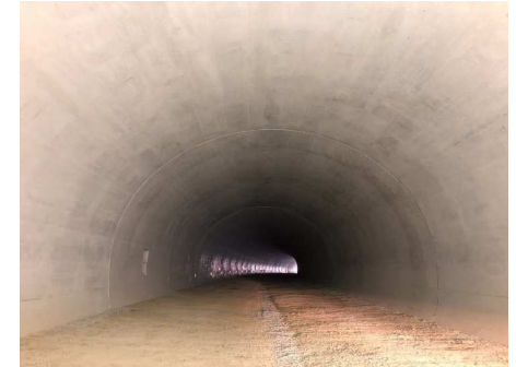
しもやぎさわ ④下八木沢第一トンネル (2021.4撮影)
