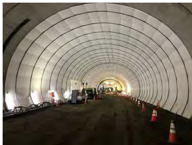
乾燥を抑制するコンクリート養生の施工状況 (3月26日完了)
