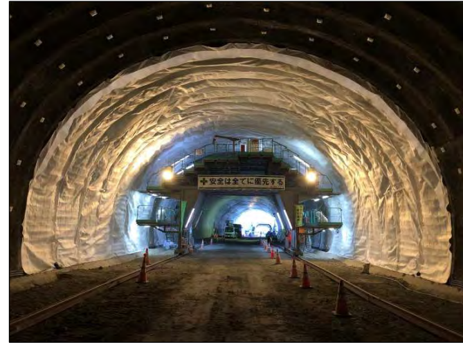
防水シートの設置状況 (2月17日完了)
