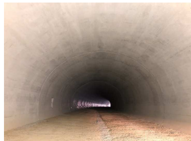
再構築工事完了 (4月5日完了)
