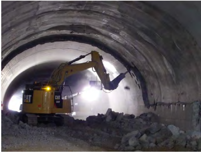
覆工取り壊し施工状況 (1月28日完了)
