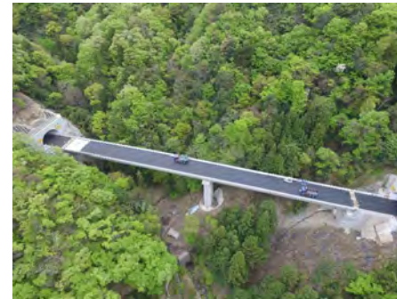
しおのさわがわ ③塩之沢川橋 (2021.4撮影)
