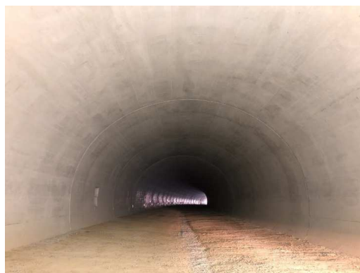
覆工コンクリートの再構築完了
