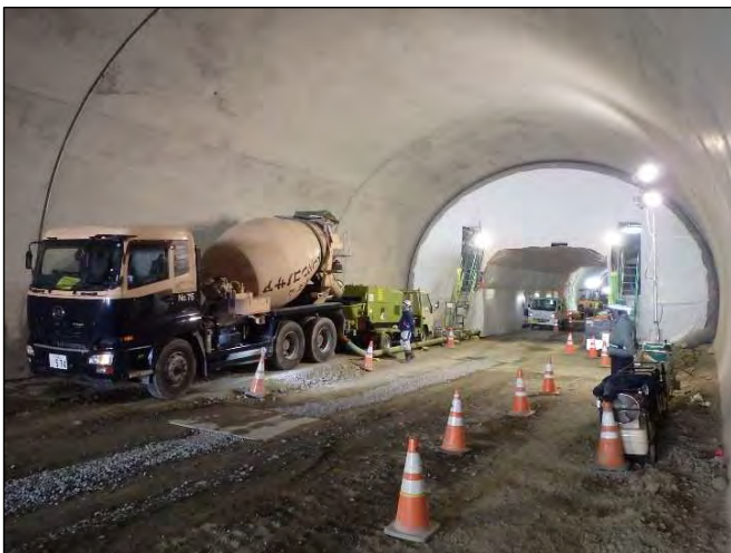
覆工コンクリートの打込み状況 (3月19日完了)
