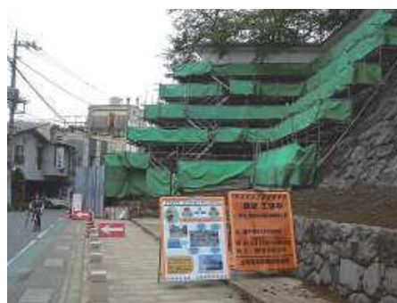
甲府城跡東側石垣の補修工事の状況
