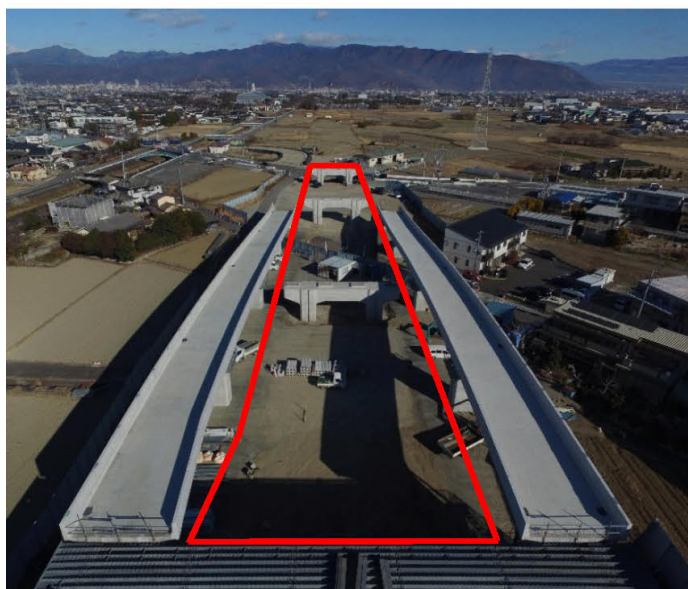
架橋位置写真
