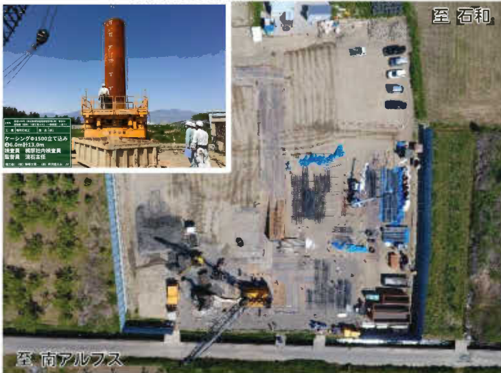
場所打ち杭施工(ドローン空撮)
