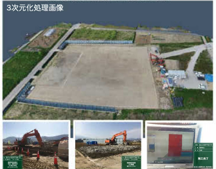
地盤改良工 ICT施工(FCM工法)
