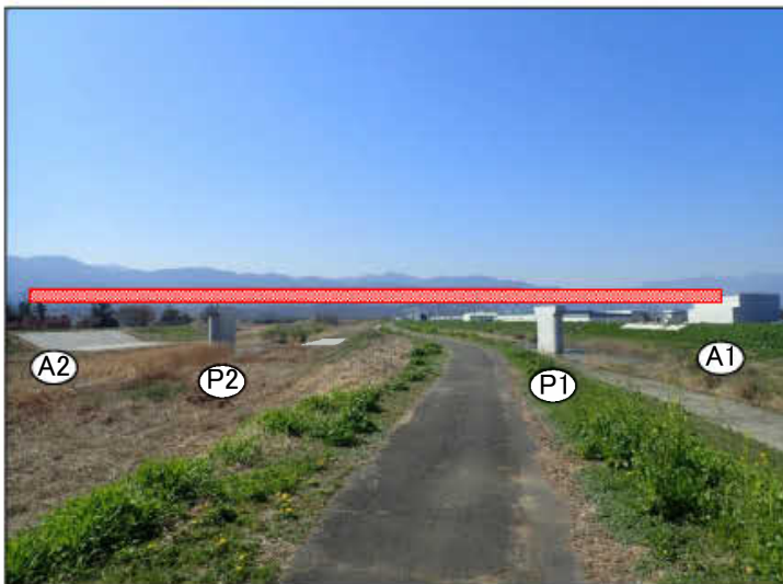
架橋位置写真
