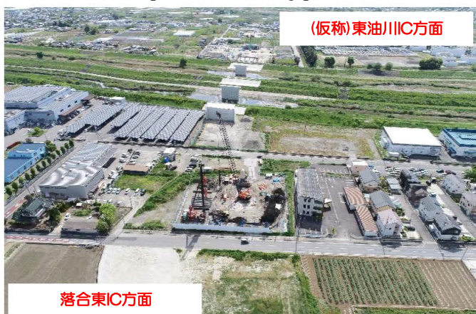
[上空からの全景]
