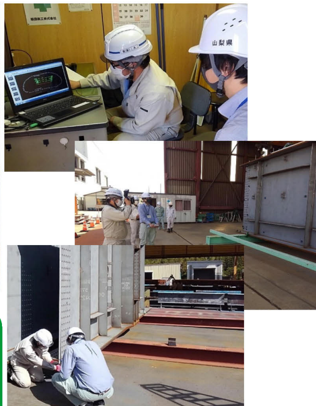
仮組立検査状況
