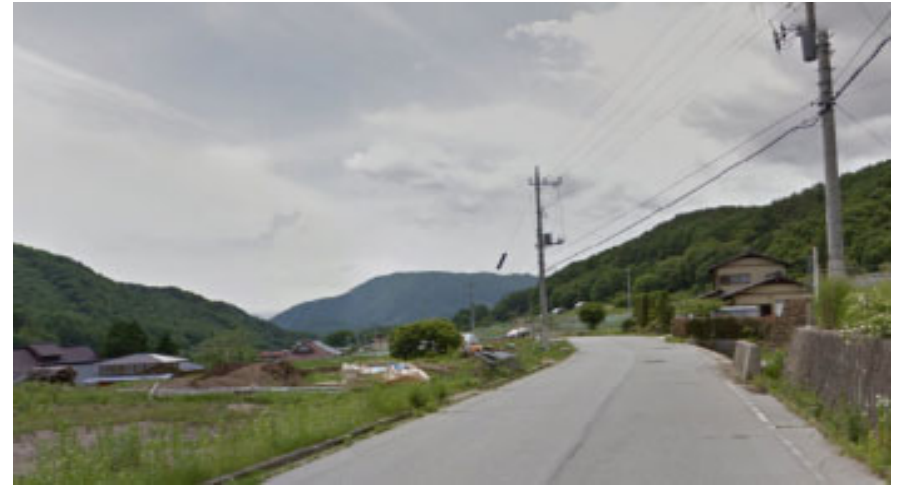
保全対象：県道原浅尾葦崎線
