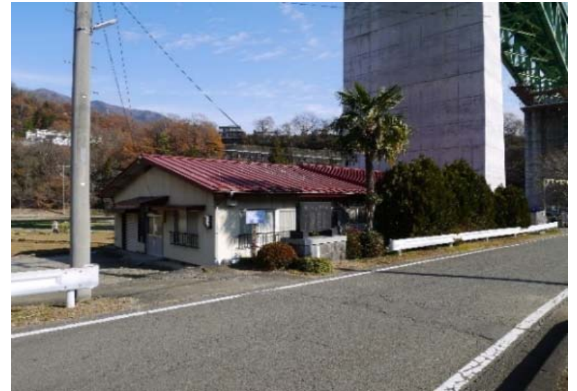
保全対象：猿橋公民館久保分館 (地区避難所)
