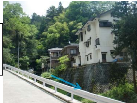
保全対象(人家・市道)
