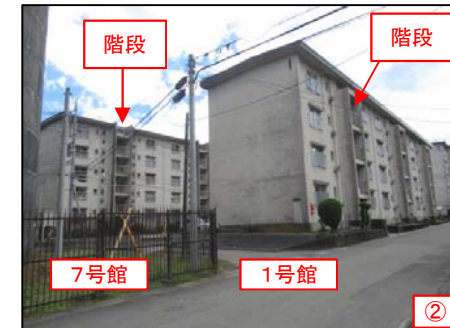
建替え住棟外観 上下移動は階段を使用 建替え後はエレベーターを設置するなど バリアフリー化を促進
